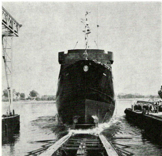
Herover: Den nye isbryder Danbjørn løber af stabelen på Odense Stålskibsværft – i august sidste år.
